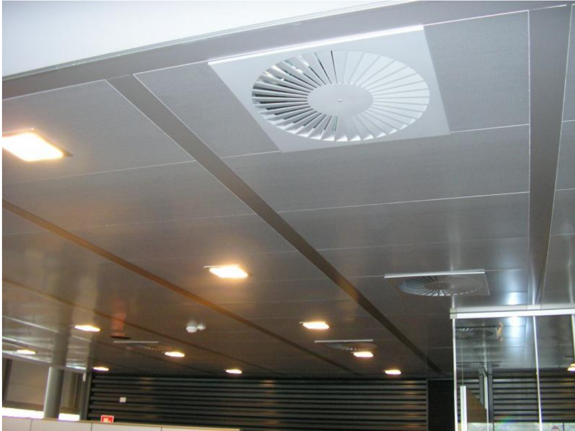
Figura 81 - Esempio di installazione di diffusori elicoidali
