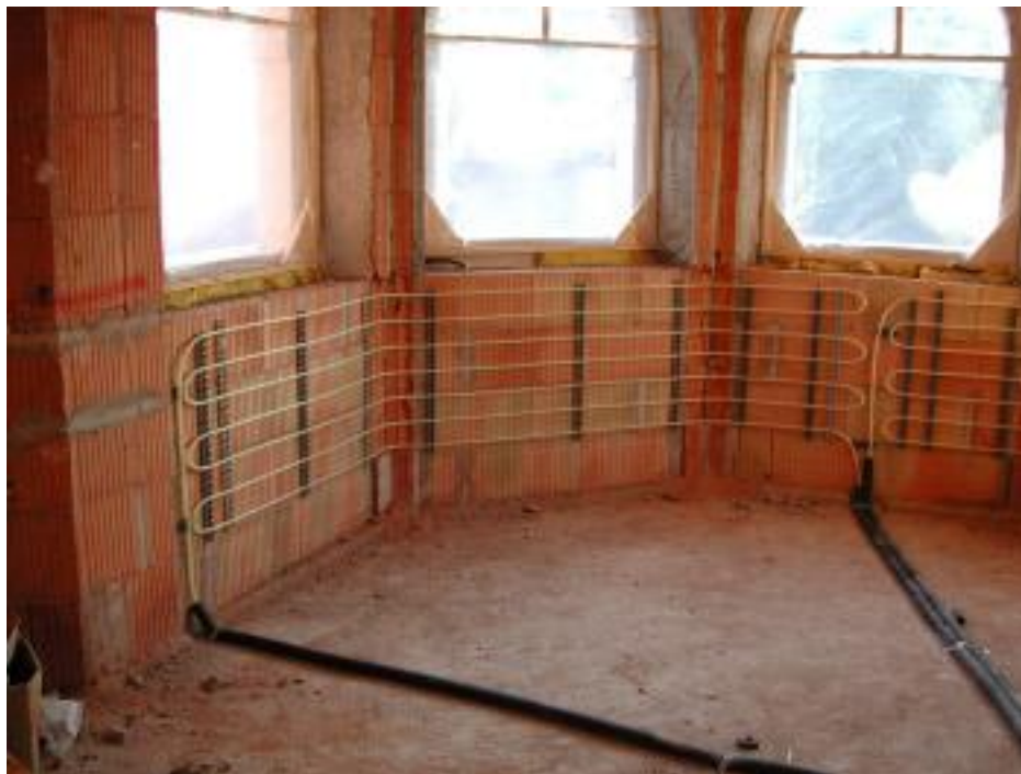
Figura 49 - Pannelli radianti a parete
