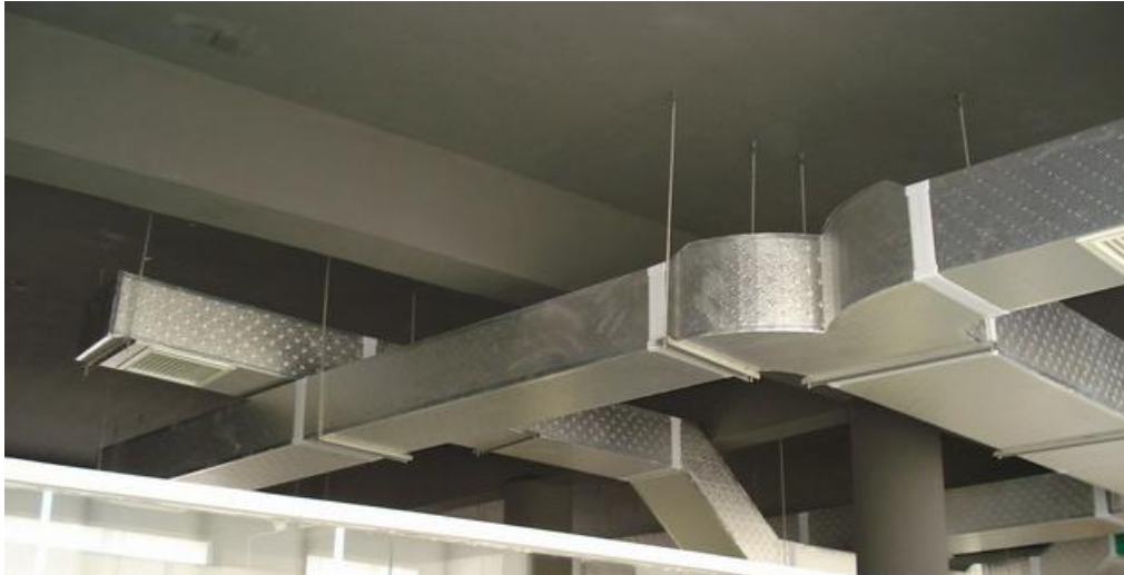
Figura 71 - Canali pre-isolati
