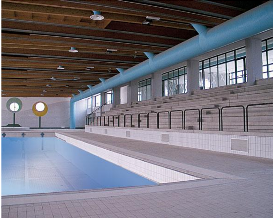
Figura 72 - Canalizzazione aria realizzata in tessuto
