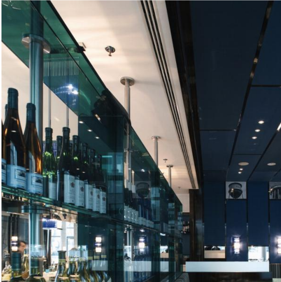
Figura 79 - Esempio di installazione di un diffusore lineare a tre feritoie
