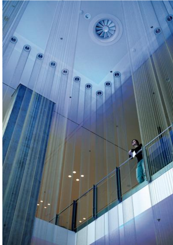
Figura 84 - Esempio di installazione di un diffusore per grandi altezze
