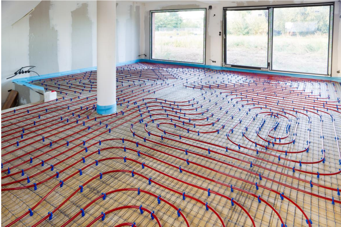
Figura 46 - Pannelli radianti a pavimento
