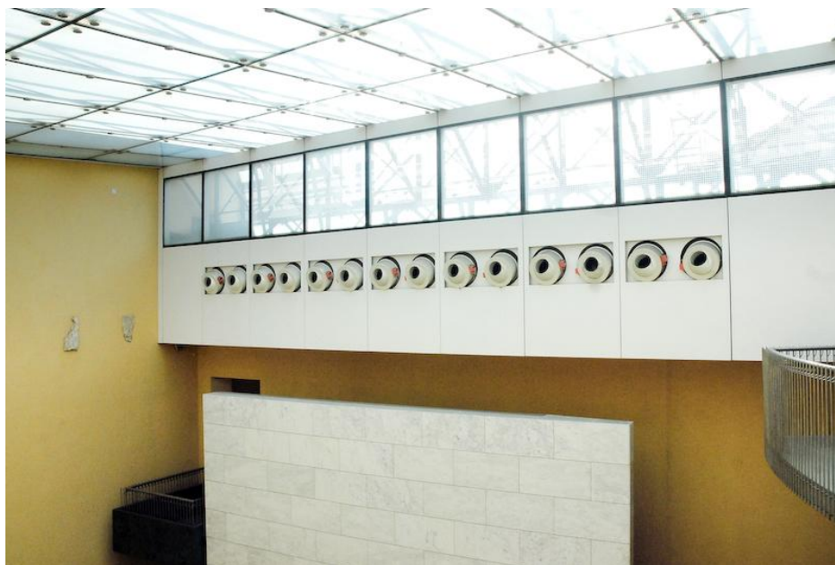
Figura 76 - Esempio di installazione di ugelli
