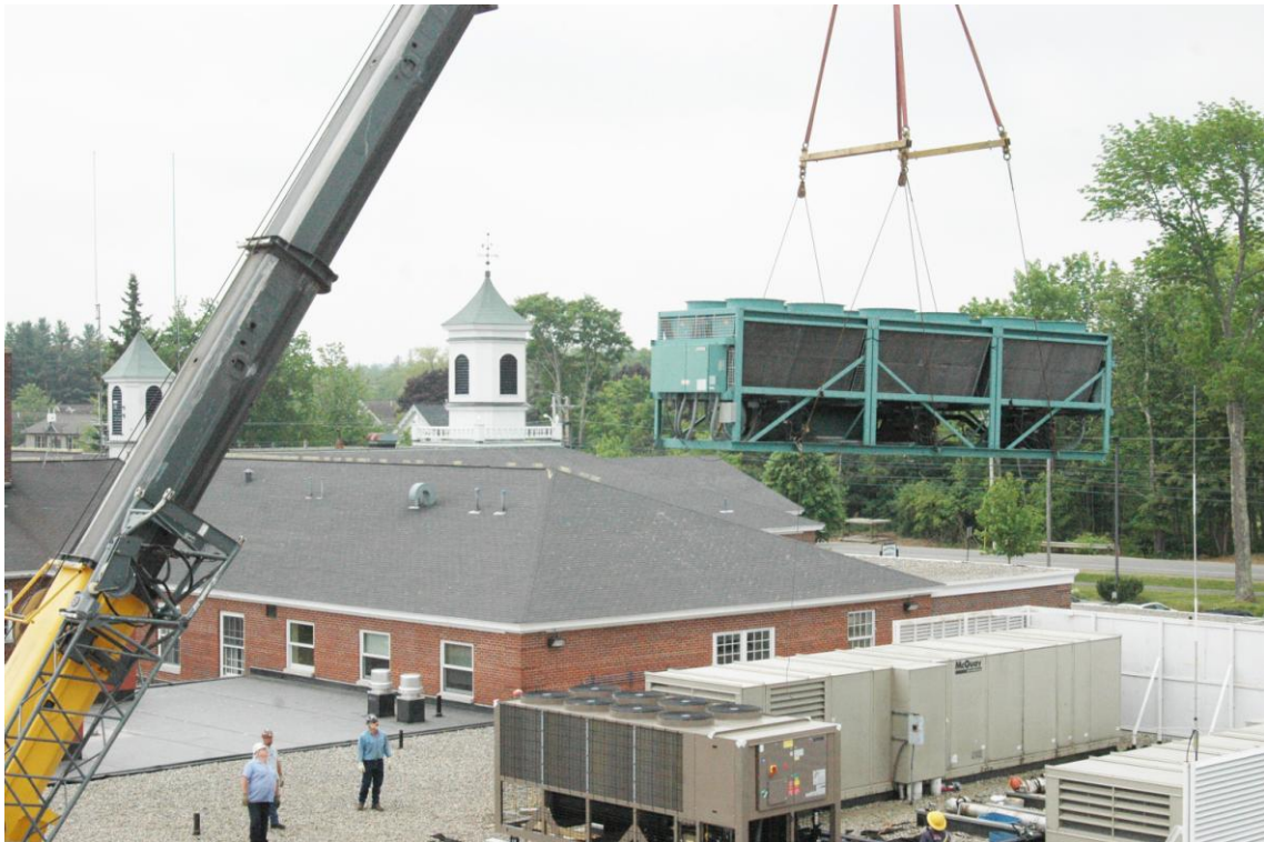
Figura 24 – Una macchina frigorifera viene installata in copertura
